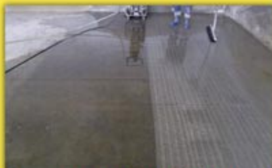
FRESATURA SU CEMENTO
